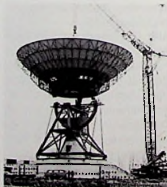
Bild 1: 130 Tonnen wiegt der Antennenreflektor der neuen Intelsat-Antenne in Burum
